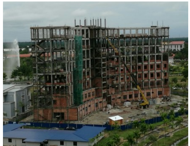
Bagunan baru FKEE yang masih dalam pembinaan
