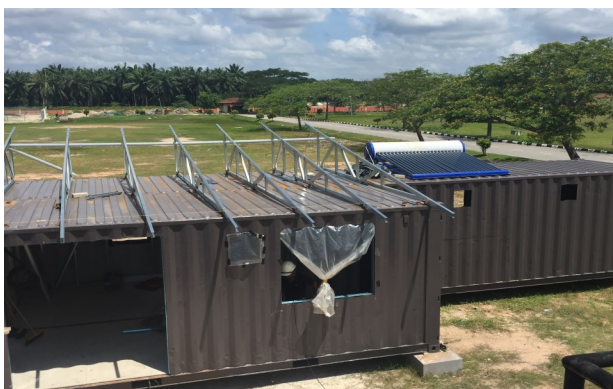
IBS Kontena dalam proses pembinaan
